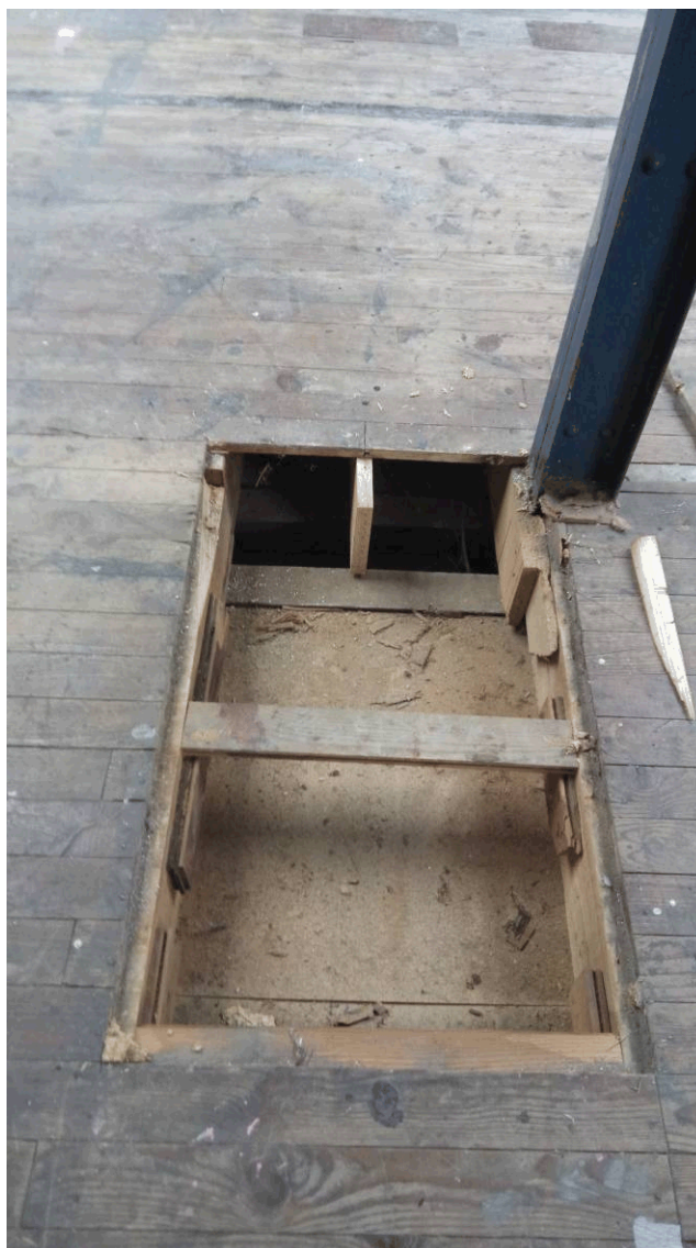
Photo 5 : sondage sur plancher au dessus de la « boîte de nuit »
