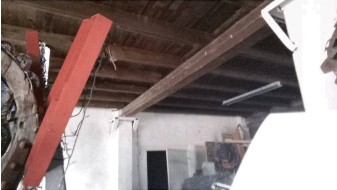
Photo 6 : sous-face de plancher sur zone stockage
