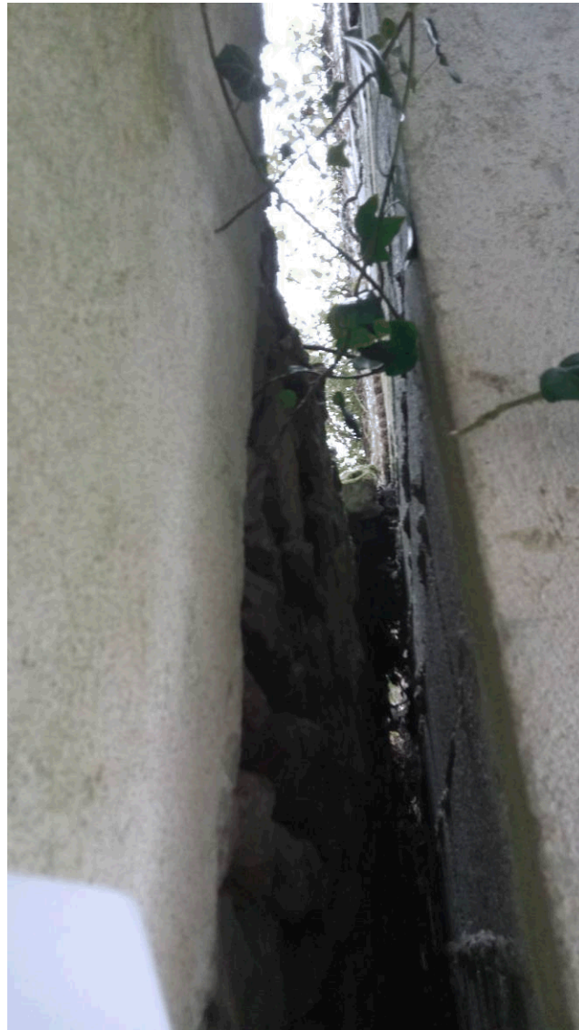
Photo 2 : mur arrière non enduit
