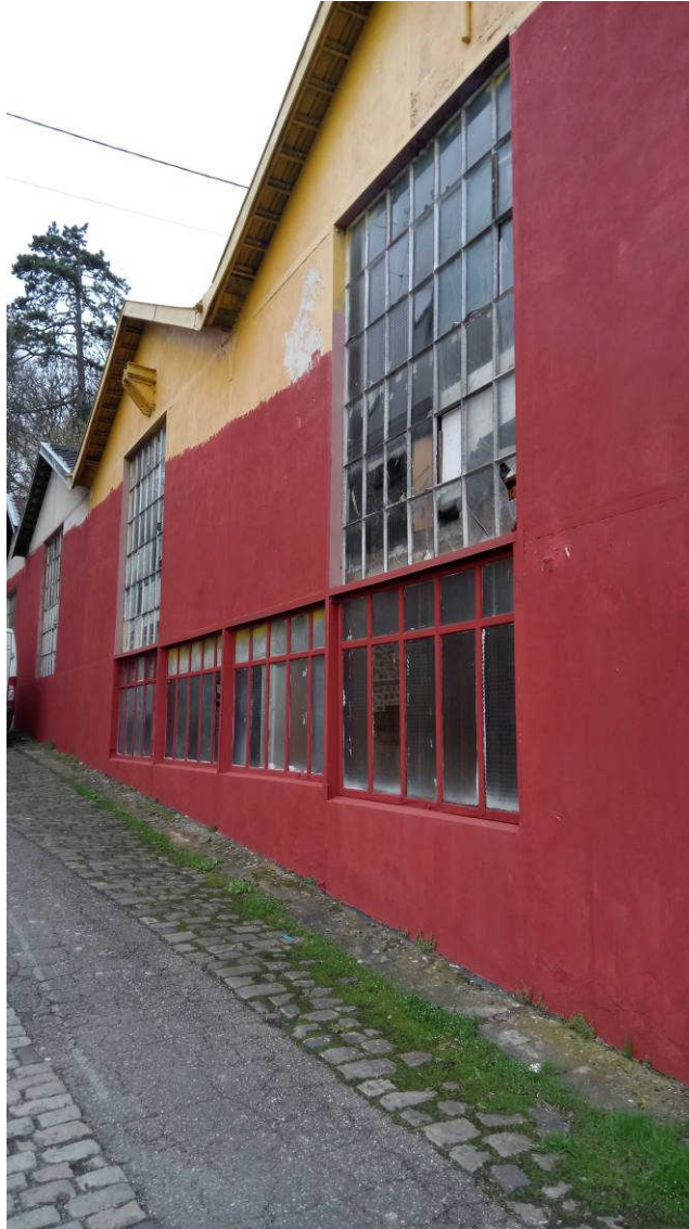
Photo 7 : menuiseries – risque contre les chutes
