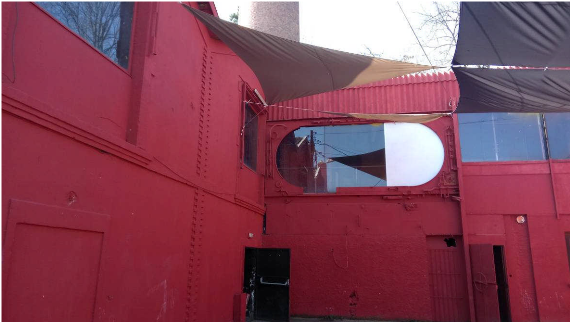
Photo 8 : menuiseries – risque contre les chutes
