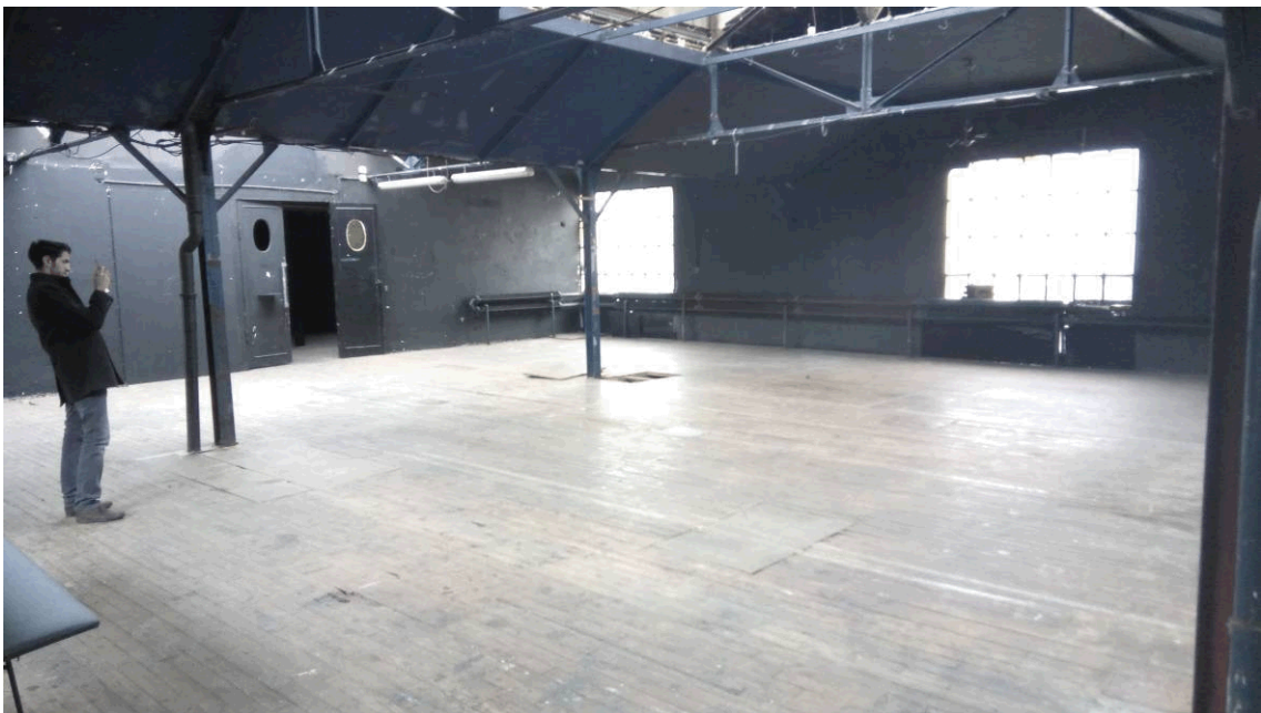
Photo 4 : Plancher sur « boîte de nuit »
