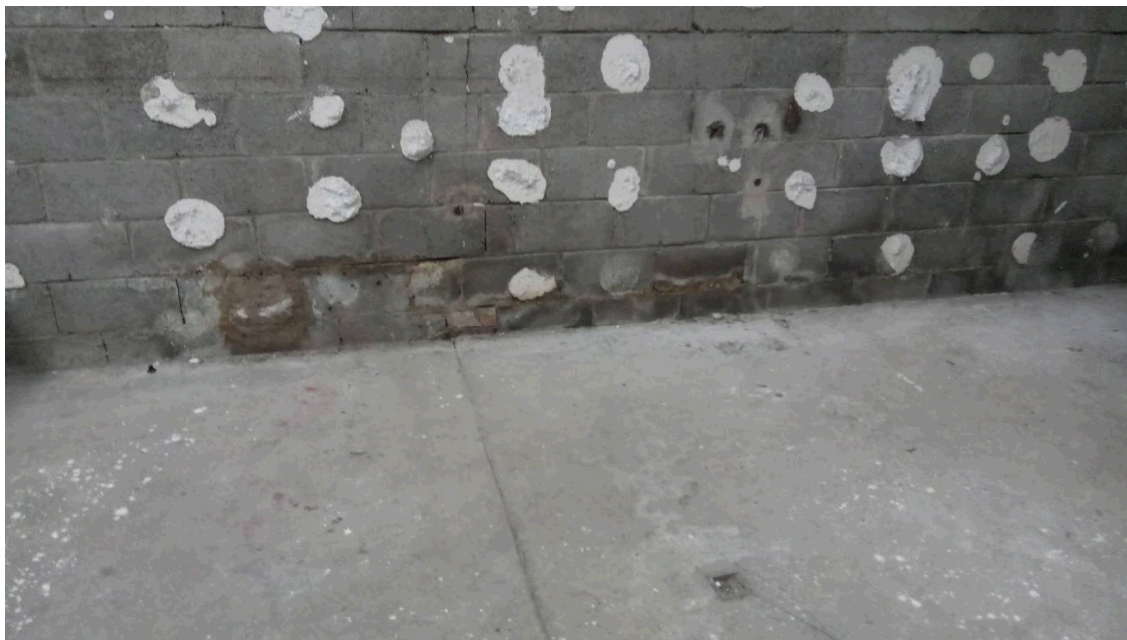
Photo 1 : Traces d'humidité sur mur arrière
