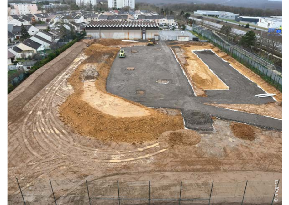
> Travaux Parc Léo Lagrange, janvier 2019
