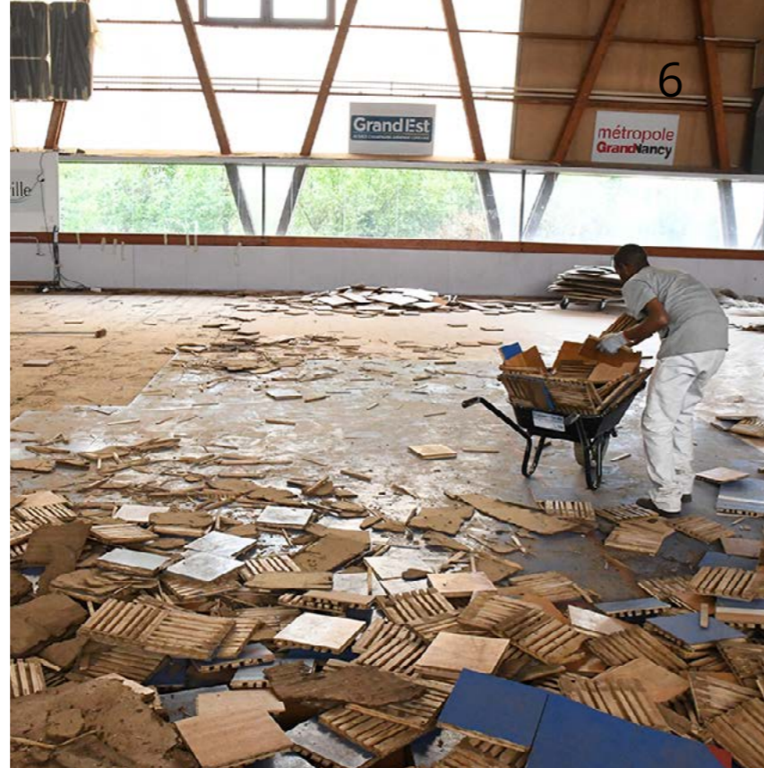
> Rénovation du sol, complexe sportif Marie Marvingt
