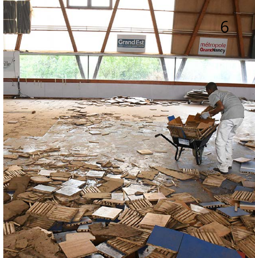
> Rénovation du sol, complexe sportif Marie Marvingt
