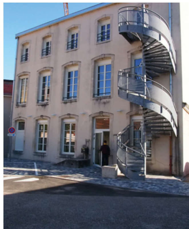
^ entrée à l'arrière du bâtiment
