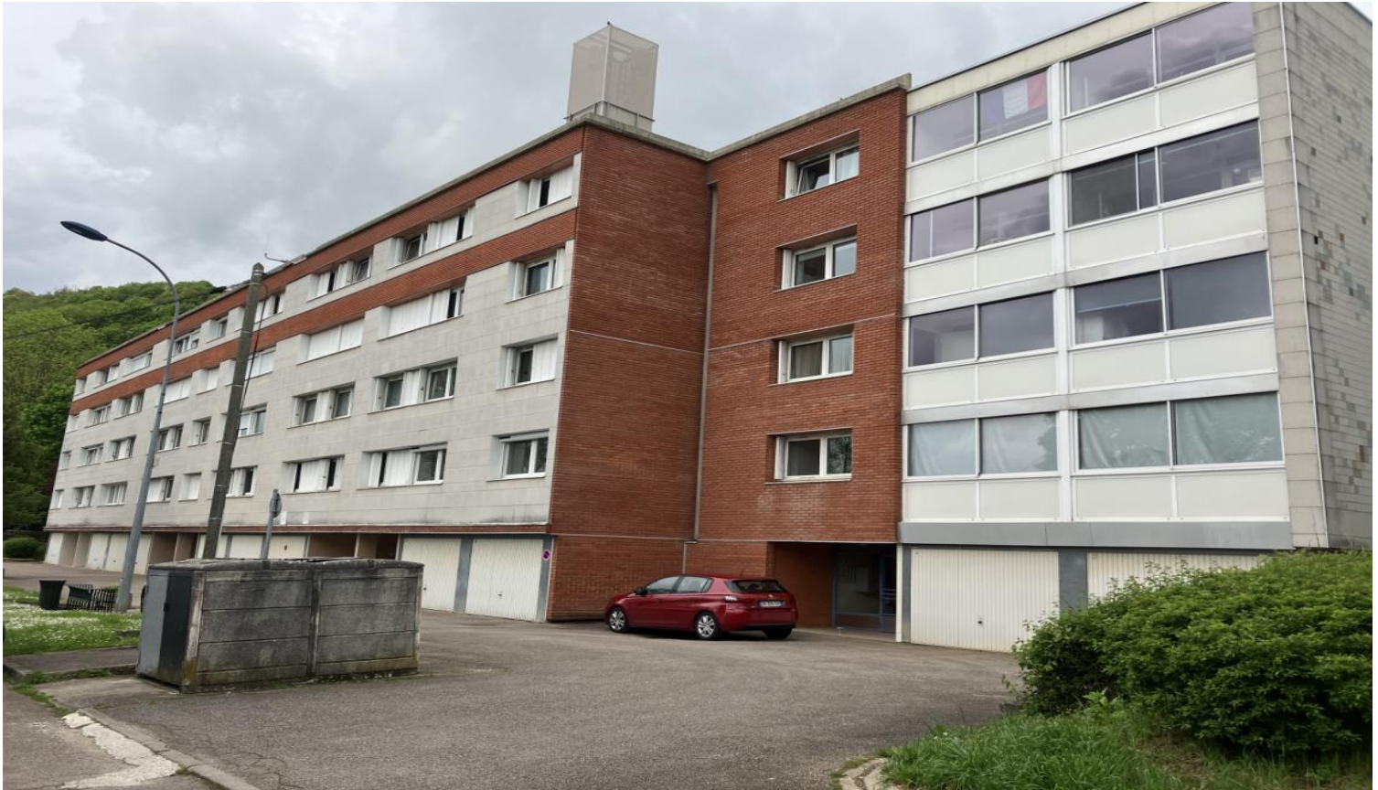
IMG 1 : Mise en œuvre de traitement acoustique en façade
