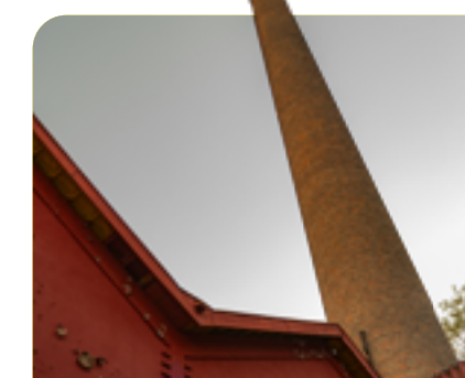
Poursuite de la réhabilitation du site des Brasseries avec la maison des Directeurs, la consolidation de la cheminée...
