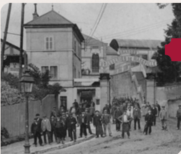
> La sortie des ouvriers
