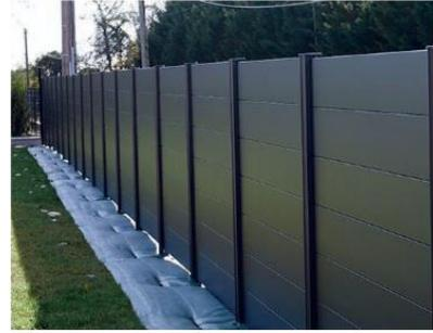
Clôture pour la limite Ouest, prévue en lames aluminium thermolaqué.
